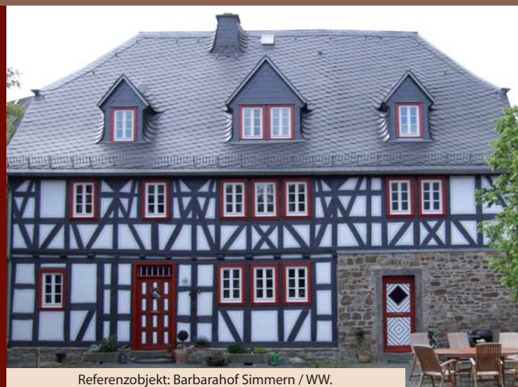
Referenzobjekt: Barbarahof Simmern / WW.
