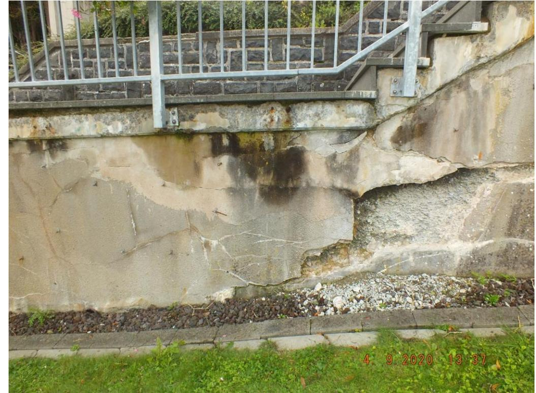
Die historische Stampfbetonwand unterhalb der Treppenanlage ist massiv geschädigt und muss dringend vor weiterem Verlust und Schädigung gesichert werden.
