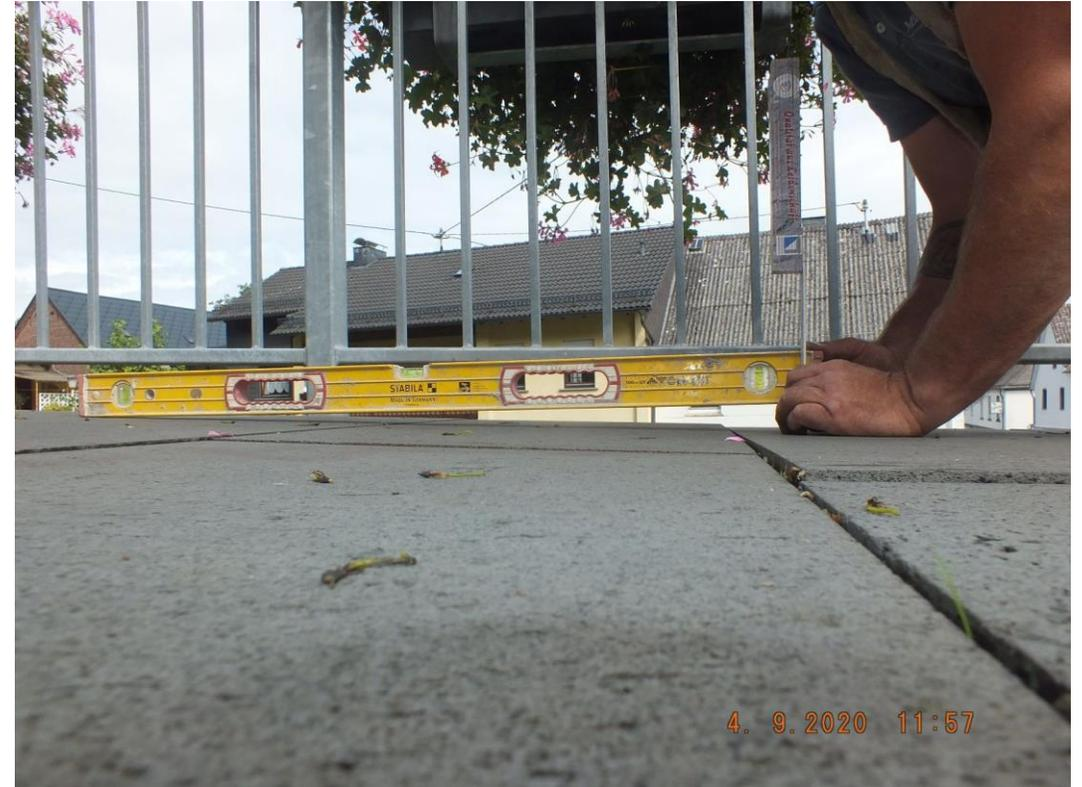
Das starke Gefälle in Laufrichtung sowie der teils glatte Plattenbelag verschlechtern den Gesamtzustand der Anlage zur Nutzung als Treppe zusätzlich und schädigen dauerhaft den Bestand durch fehlende und falsch konstruierte Entwässerung. Bereits jetzt sind zahlreiche Schäden am Plattenbelag selbst sowie am Unterbau vorhanden. Aus Gründen der Verkehrssicherungspflicht wurde während der Untersuchung die Sperrung der Treppe vorgeschlagen und durchgeführt.
