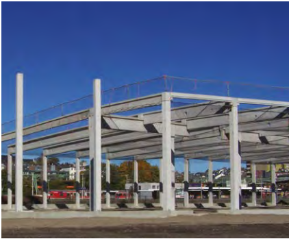
Halle aus Stahlbetonfertigteilen: Die erwartete Nutzungsdauer von 33 Jahren ist bei einer massiv gebauten Halle laut AfA-Tabellen ungefähr doppelt so hoch wie die von Holzkonstruktionen.
