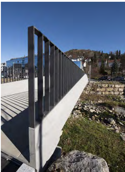
Komplett aus Textilbeton: Die Radwegbrücke in Albstadt-Ebingen
