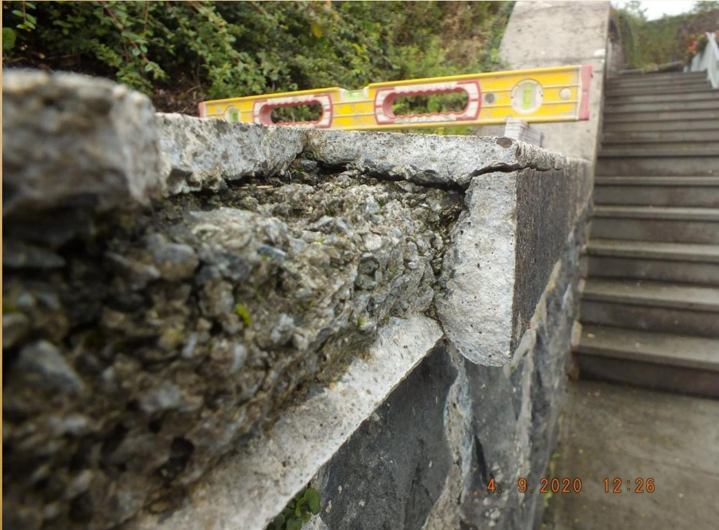
Vorgabe: Präparierter Ausschnitt Wandabdeckung Oktagon (Original aus SCHLÜSSELSTELLE): Vorsatzbeton und Kernbeton – Aufbau Bestand
