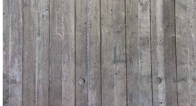
Abb. 4: Augsburg, Kongresshalle: Betonoberfläche mit Schalungsspuren – unbehandelt (Foto: Elke Hamacher)
