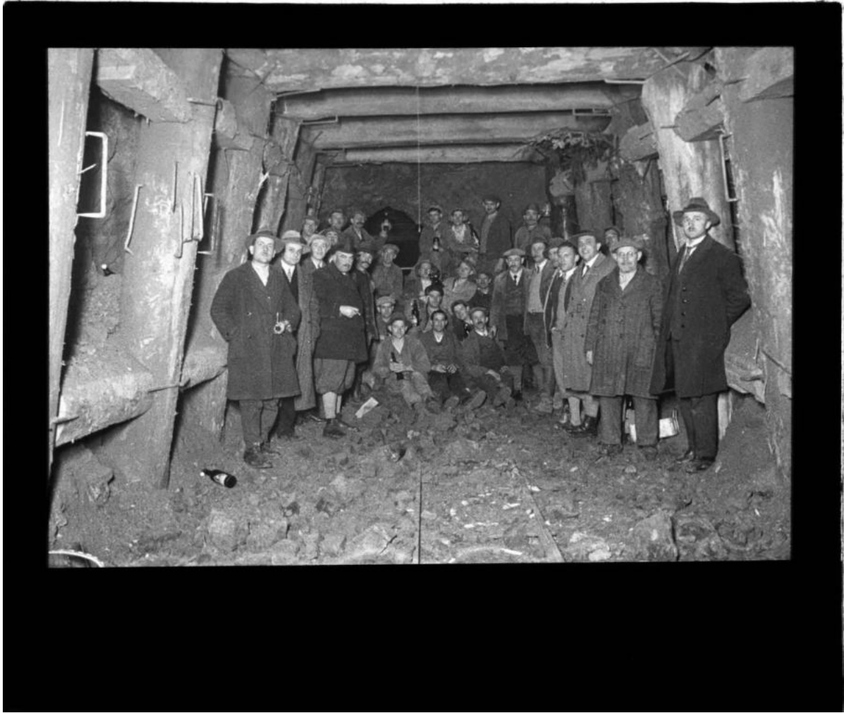
1931BA 2000/1458 [Inv.Nr.] Sternwaldtunnel während der Bauzeit:
