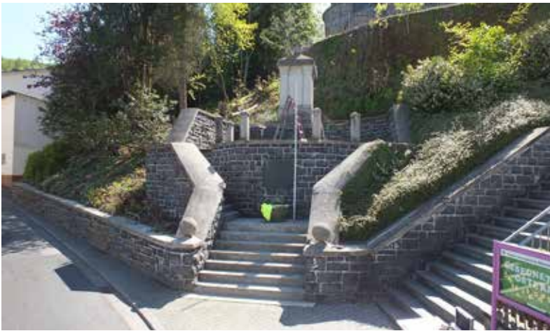
Abb. 1 Ansicht von der Straße auf das Denkmal
