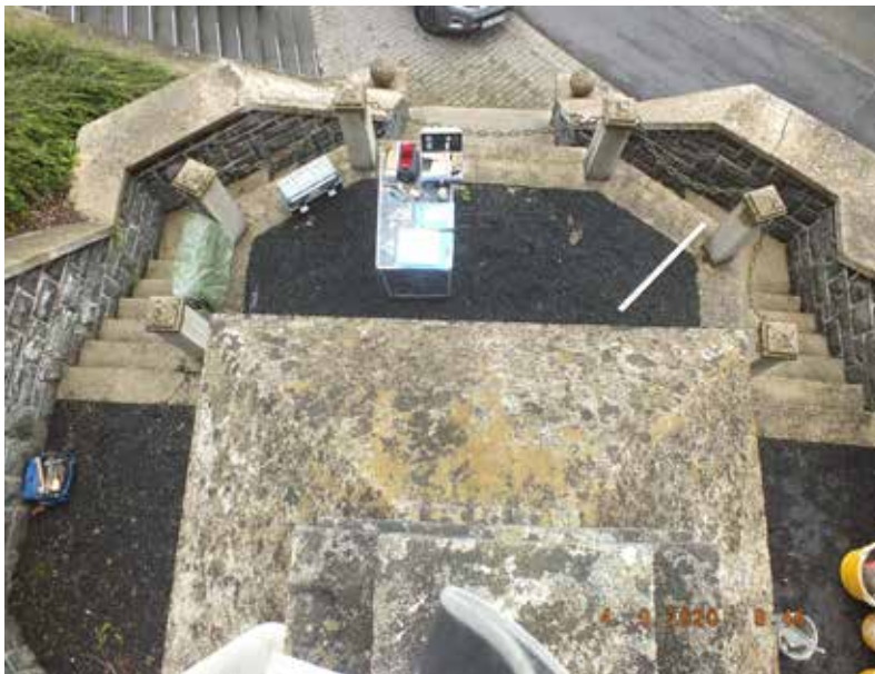
Abb. 6 Teil-Ansicht der Anlage OKTAGON von oben mit allen Bauteilen aus Betonwerkstein: Treppen, Pfosten, Abdeckungen mit Kugeln und Ehrenmal – alles Beton.
