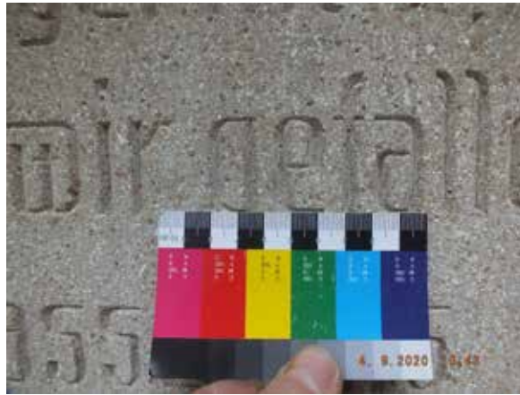
Abb. 8 Detail Ehrenmal Betonwerkstein- flächen
