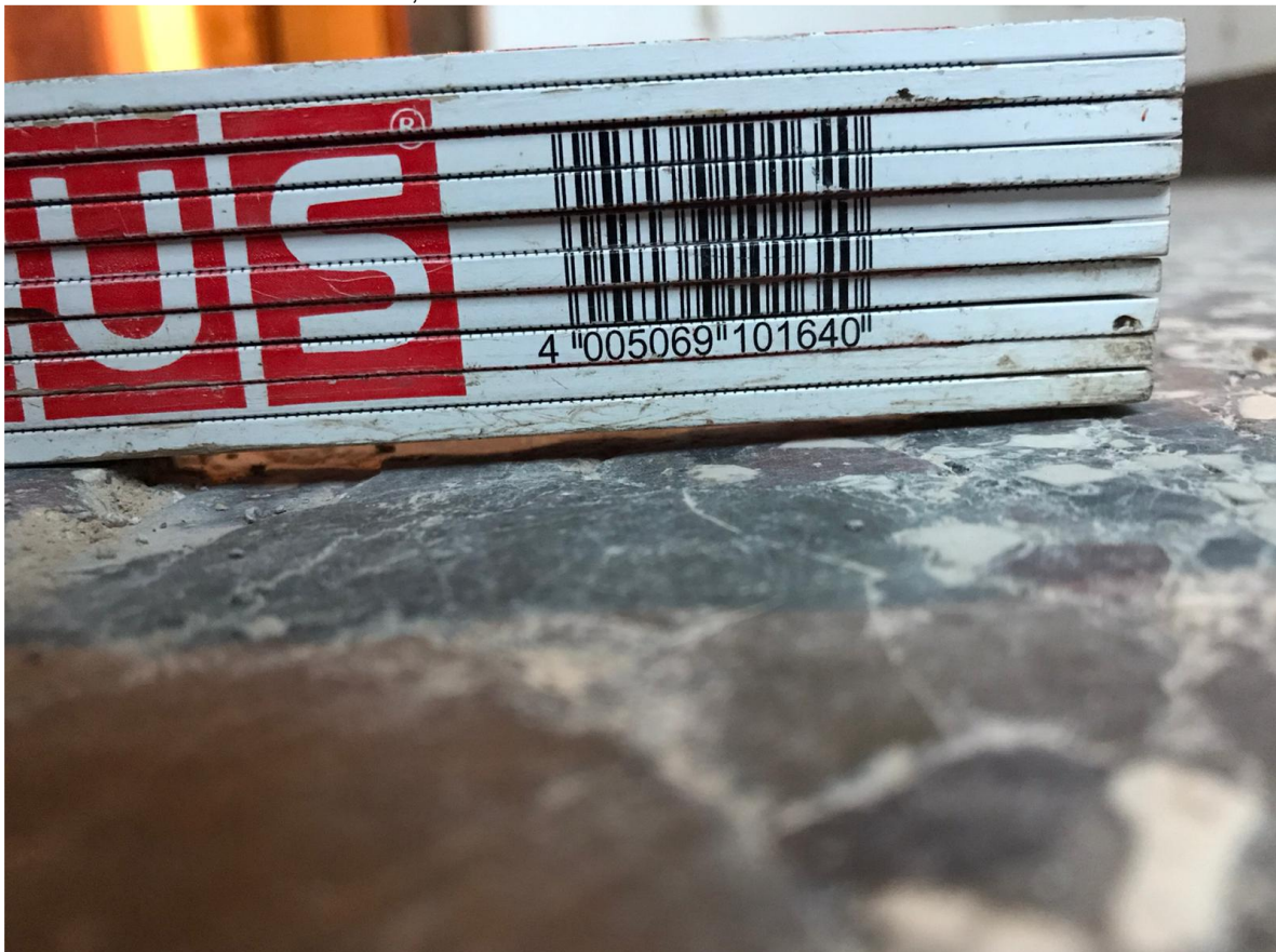
Bild 13: Höhenversatz in Fläche, hier bis ca. 6 bis 7mm.
