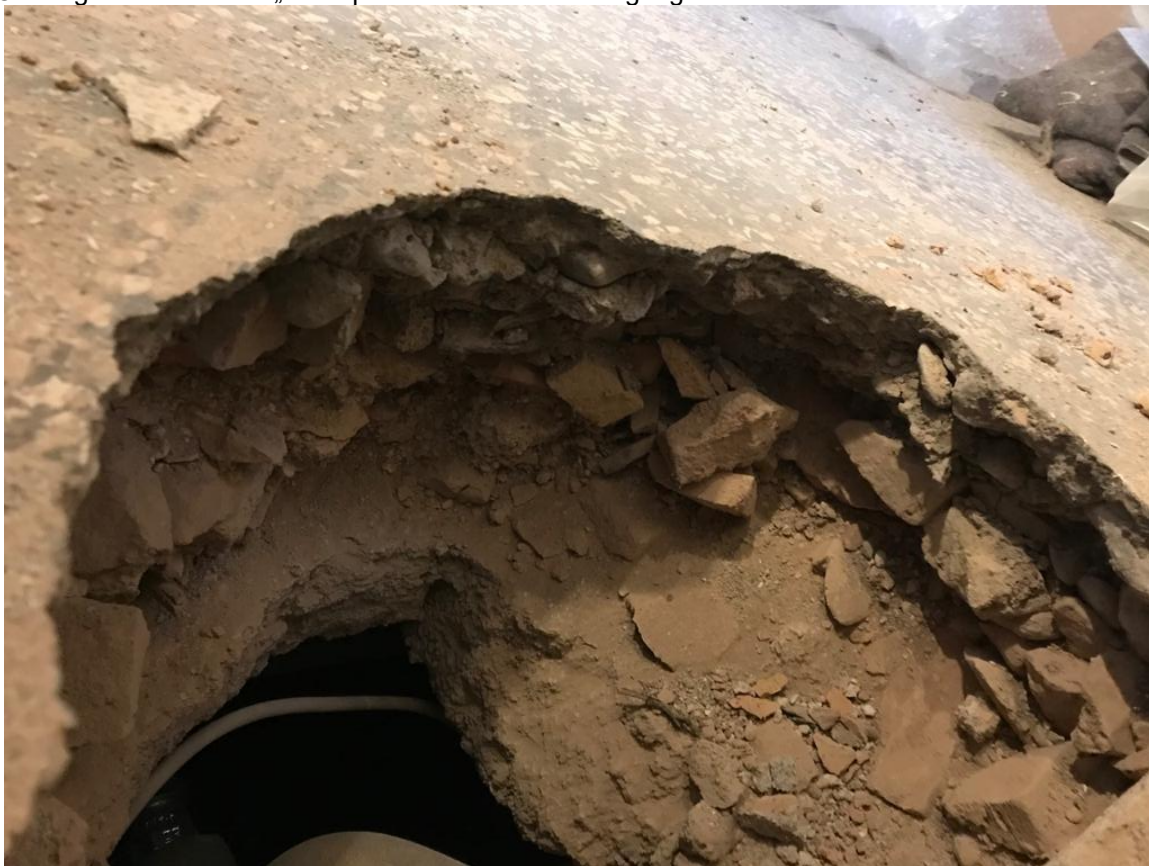
Bild 6: Blick in Aufbau Unterboden, Bodenbelag und Füllung der Kappendecke – Küche West, Öffnung nach Rückbau „Betonplombe“ am Rohrdurchgang der Heizrohre
