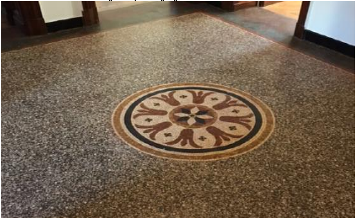
Bild 3: Übersicht Terrazzo-Belag im Foyer/ Eingangsbereich
