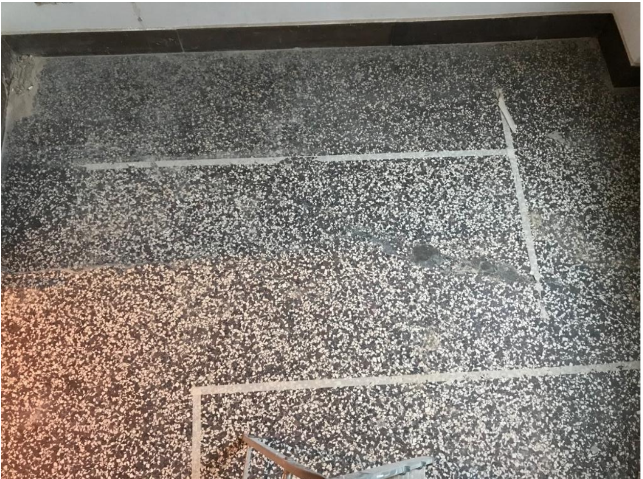
Bild 5: Übersicht Fläche Küche im Anbau West
