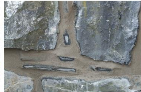
Abb. 8 (links) und 9 (rechts): Wiederherstellung der Mauerkrone einer Natursteinwand als Auflager für einen Dachstuhl.
