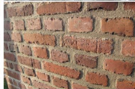
Abb. 10 (oben) und 11 (unten): Verfüllung von Naturstein- und Ziegelsteinmauerwerk mit Heißkalkmörtel.
