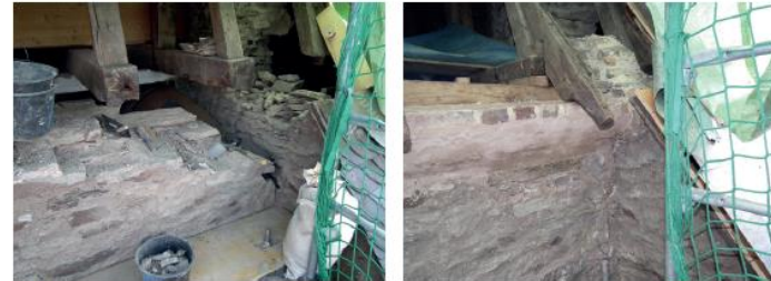
Abb. 8 (links) und 9 (rechts): Wiederherstellung der Mauerkrone einer Natursteinwand als Auflager für einen Dachstuhl.
