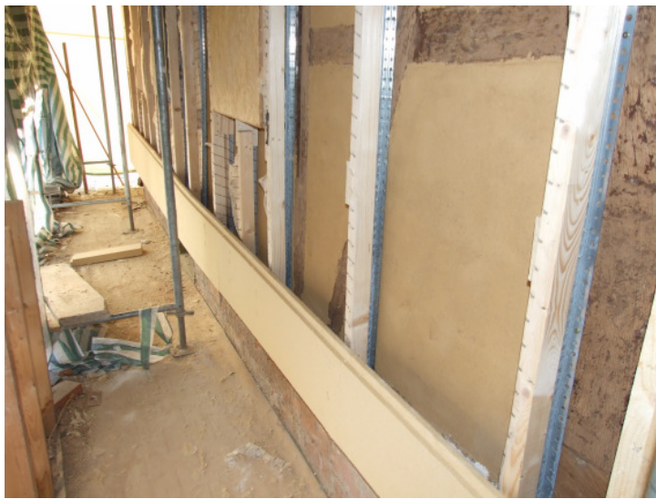
Bild 5: Lamda-Schienensystem auf Mauerwerk montiert
