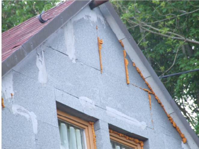
Bild 2: das schlechte Beispiel – Detail Anschluss an Fachwerk
