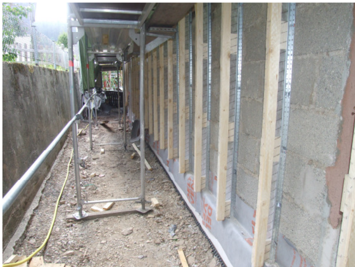
Bild 5: Lamda-Schienensystem auf Mauerwerk montiert
