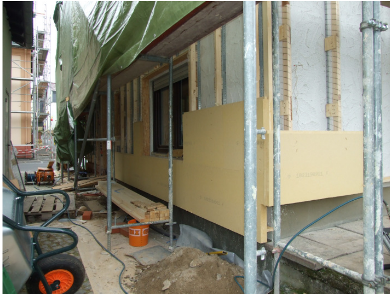
Bild 5: Lamda-Schienensystem: Montage der Putzträgerplatte aus Holzweichfaser
