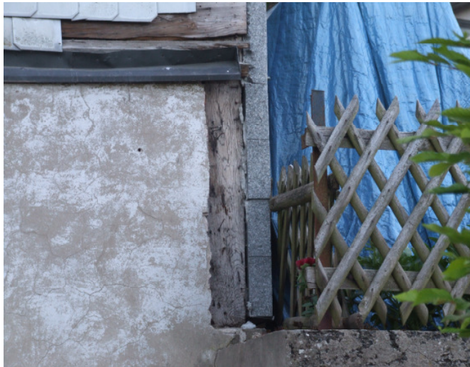
Bild 2: das schlechte Beispiel – Detail Anschluss an Fachwerk
